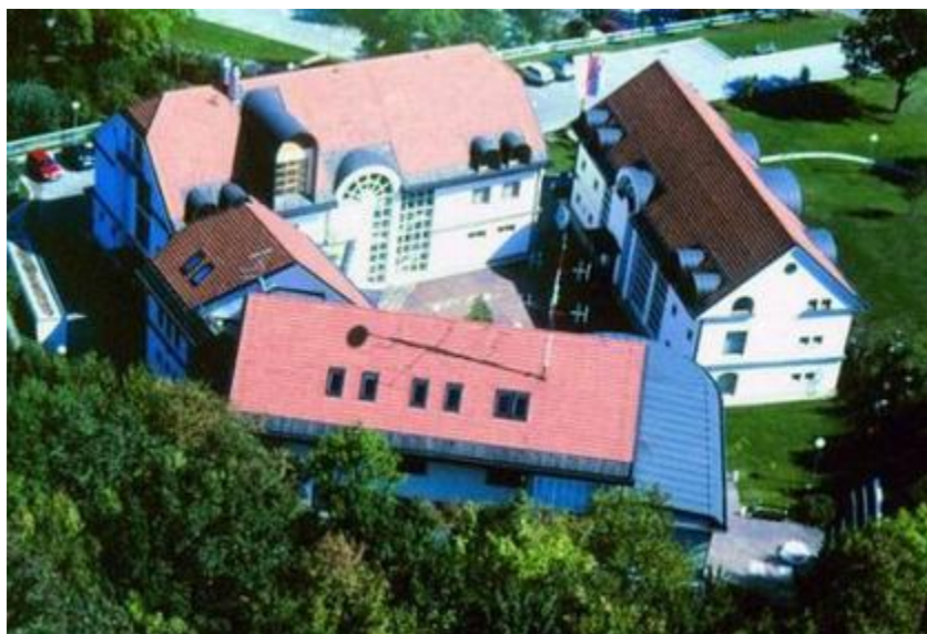
Slika: Izobraževalni center za zaščito in reševanje na Igu
