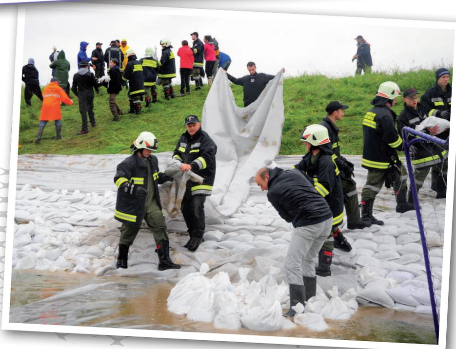
Ein Hochwasserdamm wird mit Sandsäcken gesichert.
